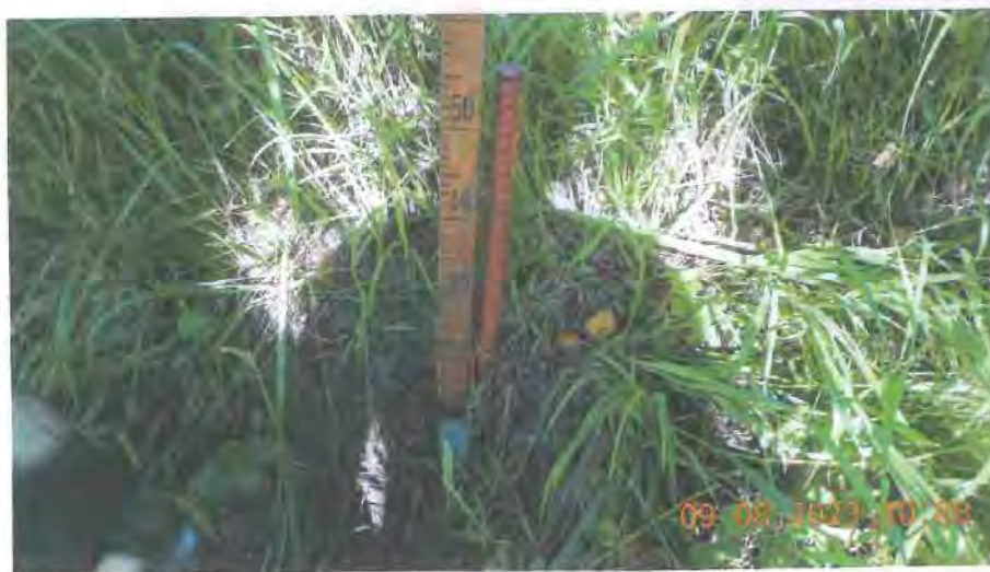
Рисунок 17 – Оголовок сваи над землей на 56 см
