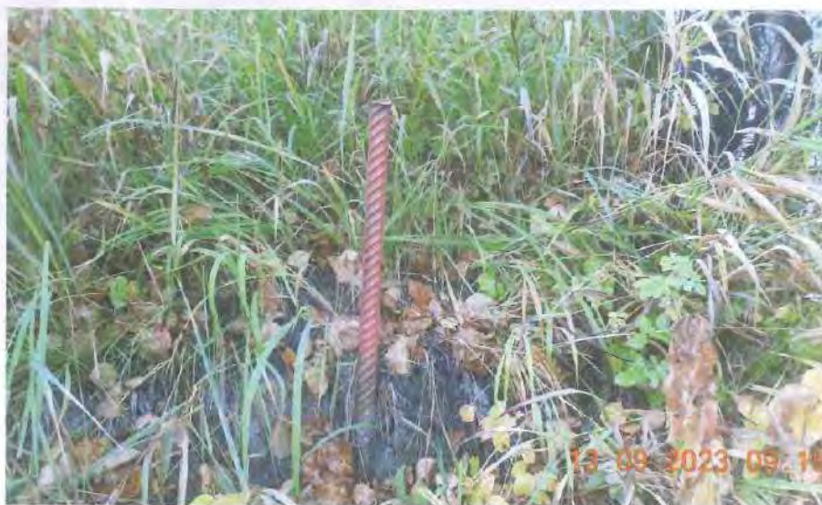
Рисунок 11 – Оголовок сваи над землей на высоте 56 см
